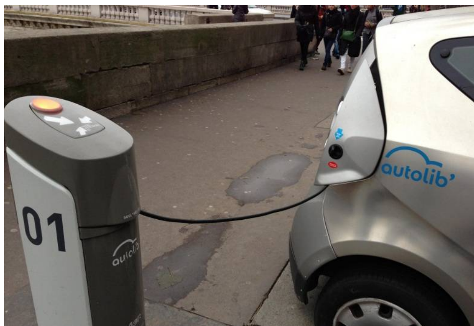
図表 4-3 充電中の EV
