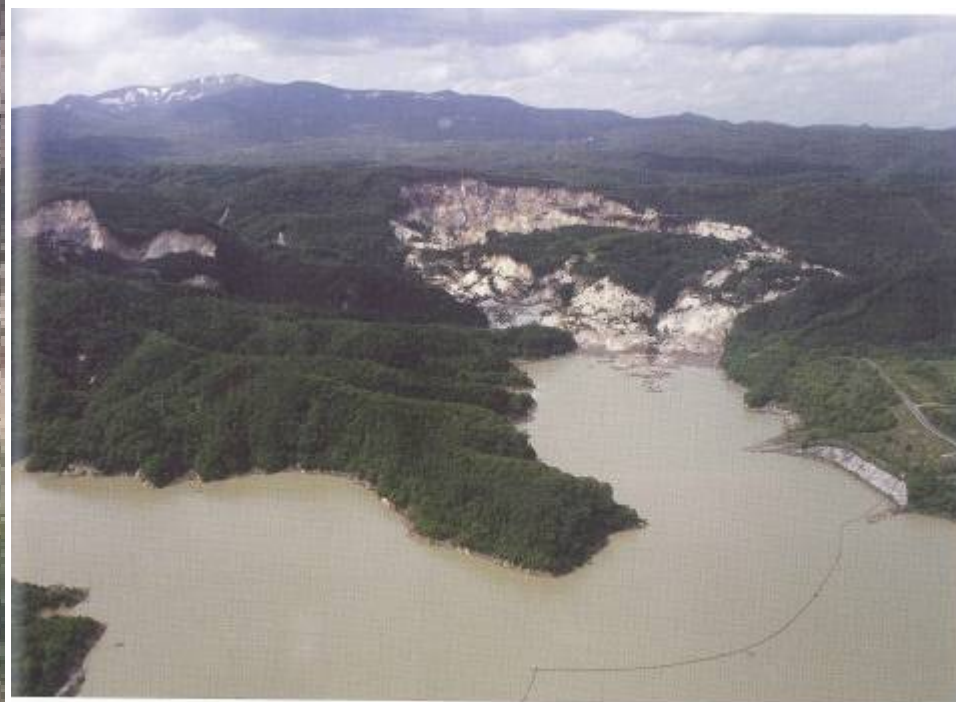
栗駒地区（荒砥沢ダム上流部） 国内最大規模の地すべりが発生した荒砥沢ダム上流部。 そこを流れていた市道荒砥沢線が3、300メートルにわたり消滅してしまいました。
