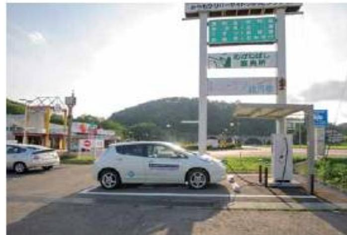
宮沢賢治の「銀河鉄道の夜」をイメージさせる「あがね橋」の上流に位置する「道の駅 みやもり」にも急速充電器を設置。雷避け用の屋根も取り付けている。
