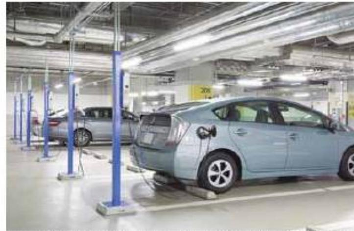
2015年1月に稼働開始した125基の充電器。一般用の平面駐車スペースの8割をカバーしている。車の後方に歩行用の通路を確保するため、専用ポールと充電器を一体化させた新タイプを開発した。
