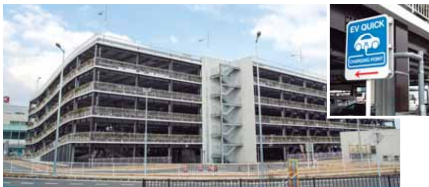
平成26年7月から稼働を開始した国内線側の立体駐車場。5階建て6層で、平面部分も含め837台収容できる。駐車場入口には充電器の案内板を掲示。
