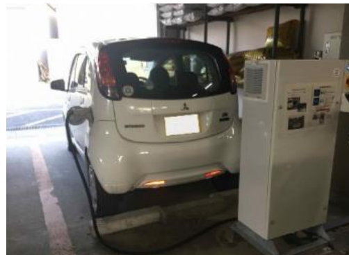
公用車EVと充放電機外観
