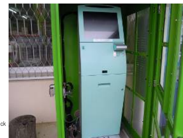
充電を開始するにはこのE-Quick端末に会員カードをタッチする
