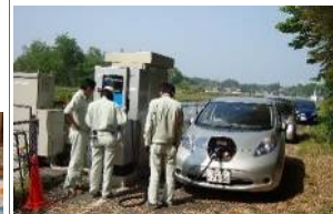
小水力発電で作成した電気を、EVに充電する実証実験を実施中
