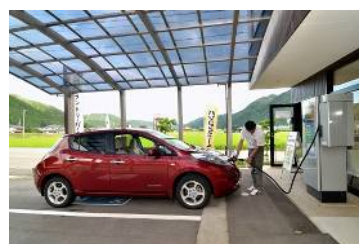
郡上市の煙中水道が設置したコインランドリーの充電施設
