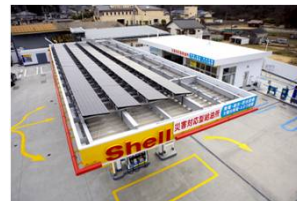
発電・給水・貯水設備を備えた災害対応型給油所では太陽光パネルも設置
