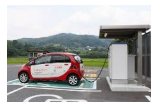
道の駅くめなんに設置された急速充電器
