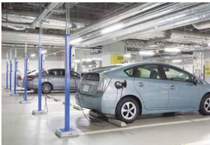
2015年1月に稼働開始した125基の充電器。一般用の平面駐車スペースの8割をカバーしている。車の後方に歩行用の通路を確保するため、専用ポールと充電器を一体化させた新タイプを開発した。
