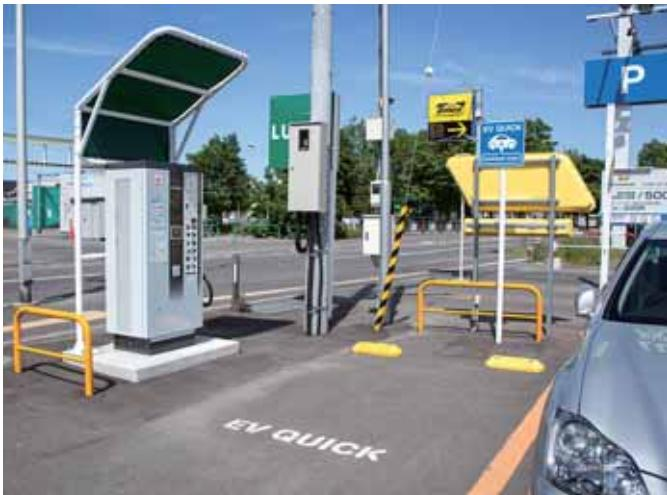
積雪に備えて雪除け屋根を設置したほか、通常はステッカーで貼られる充電場所の案内表示マークは除雪車で剥がれないよう塗装に変更。
