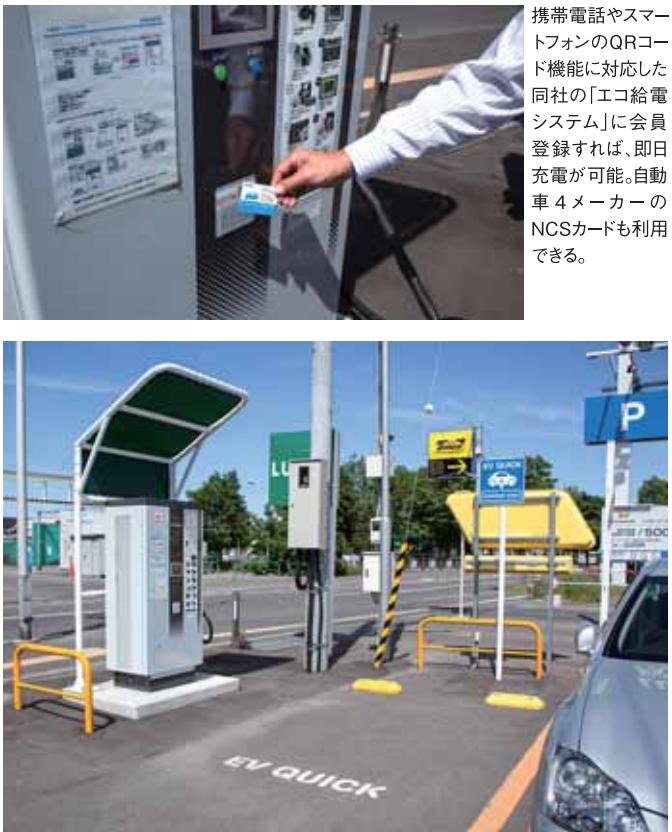
積雪に備えて雪除け屋根を設置したほか、通常はステッカーで貼られる充電場所の案内表示マークは除雪車で剥がれないよう塗装に変更。
