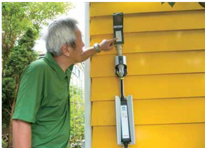
家の壁面に充電設備を設置。充電は、充電用コンセント手元スイッチで操作できるほか、充電時間をタイマー設定することも可能だ。
