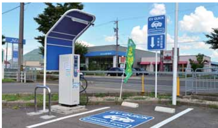
誘導看板や充電用駐車スペースのラベルなど、分かりやすい導線を整備。充電設備には屋根を取り付け、雪対策も施している。
